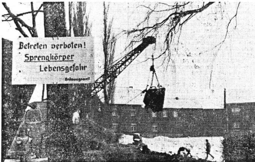
„Sprengkörper“ verkündet das Schild an Bellinghovens „Maar“. Der riesige Bagger holt die Schlammassen aus dem Weiher. Strohballen sind angefahren, die als Schutz gegen umherfliegende Sprengkörperteile dienen sollen. Foto: ju.
